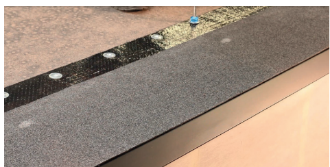
7. Remsan fästs in mekaniskt i underlaget.
