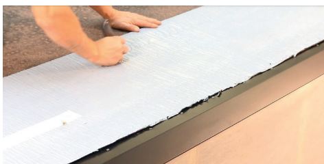
5. Gör ett snitt i releasefilmen med knivens baksida för att ej punktera tätskiktet.
