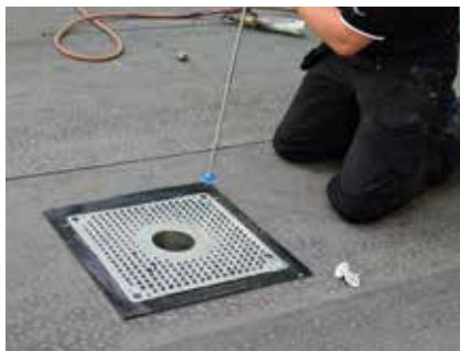
1. Placera brunnen och fäst in brunnsflänsens alla fyra hörn i underlaget.
