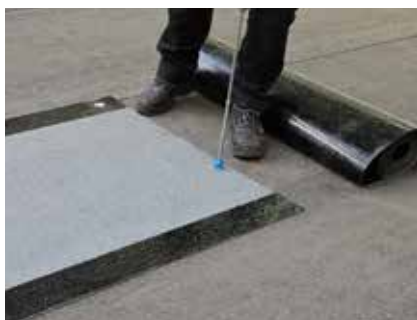
4. Fäst in rännalsvåden mekaniskt i underlaget.
