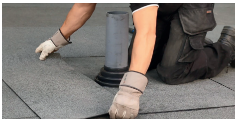
8. Placera den övre delen av kappan så den linjerar med stosens övre sida.
