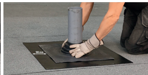
3. Placera stosen och se till att intäckningskragen når minst 100 mm utanför stosen åt alla håll. Värm fast stosen i den underliggande intäckningskragen.
