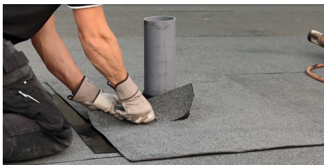
5. Skär ut för stosen. Var försiktig så att inte stosen skadas.
