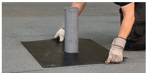
1. Placera intäckningskrage av kvalitet minst YEP 3500 över genomföringen.
