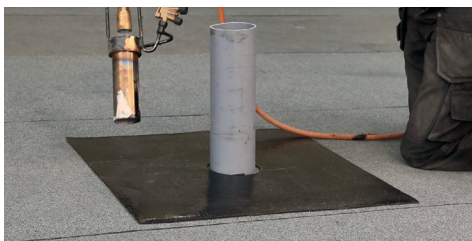
2. Värm bort intäckningskragens plastfilm.
