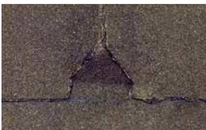
4. Skär till i nederkant och svetsa våderna mot trekantstlisten.
