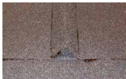
5. Montera Matakil listtak mellan trekantslisterna.
