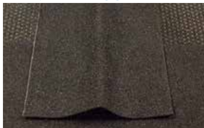
2. Mät ut och montera remsa av Matakil Listtak över trekantslisten, remsan svetsas mot hela listen och fästs mekaniskt utanför trekantslisten. Lämna understa delen av remsan osvetsad.
