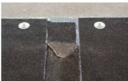
4. Montera Matakil Listtak mellan listerna. Fäst in mekaniskt i ovankant.
