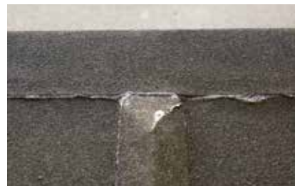
6. Avsluta med att montera nockkappa ned till trekantstlisten.
