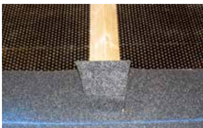
1. Montera lister ovanpå underlagstäckningen, fortsätt sedan med fotkappan. Skär ut för listen enligt bild.
