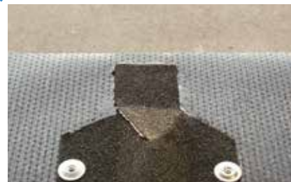
3. Fäst in remsan mekaniskt i underlaget.
