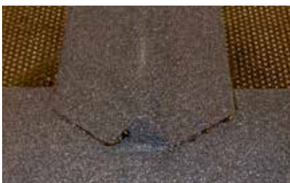
4. Svetsa remsan mot underlaget och listens avslut. Var extra noga med att använda rätt mängd värme för att undvika för stora uttrinningar av asfalt.
