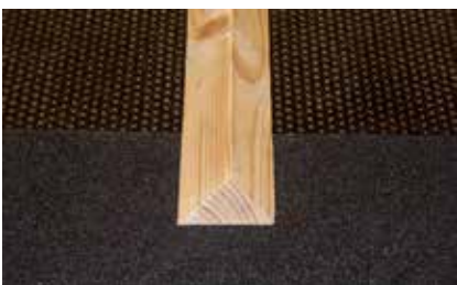
1. Montera lister ovanpå underlagstäckning och fotkappa.
