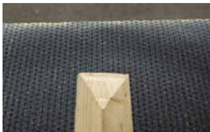
1. Montera trekantslisterna ovanpå underlagstäckningen.
