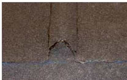
5. Avsluta med att helsvetsa en kapp över listen. Var extra noga med att använda rätt mängd värme för att undvika stora utrinningar av asfalt.
