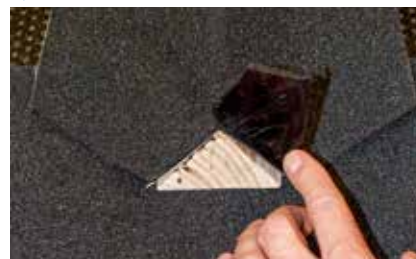
3. Snedskär remsans kanter och skär ut för listavslutet.
