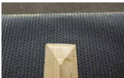
1. Montera trekantstlisterna ovanpå underlagstäckningen.
