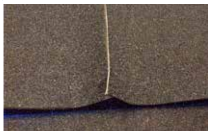
3. Anslut med Mataki Listtak mellan trekantstlisterna. Våderna ska mötas på toppen av trekantstlisten.
