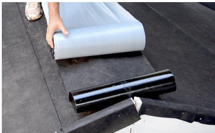
2. Täcknocken med Matak Haloten® Nock- & Rännalsremsa.
