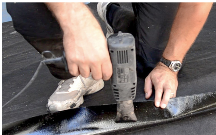
3. Varmluftspistol skall användas vid låga temperaturer. För bättre vidhäftning, använd Matak Asfaltprimer. Primern ska vara helt torr innan nockremsa läggs på.
