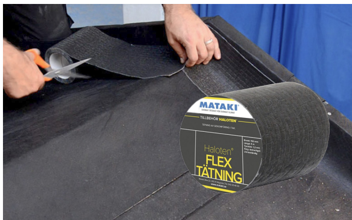
4. Täta nocken med Haloten® Flex tätning.
