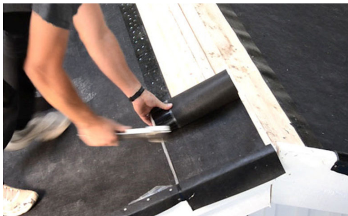
1. Skär underlagsduken så att den når ända upp inock.
