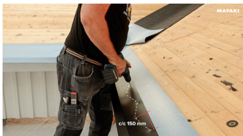
2. Montera plåten över Haloten® Fotplåtsremsa. Låt releasefilmen på Haloten® Fotplåtsremsa vara kvar vid montage av fotplåten.
