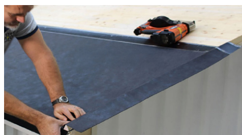
9. Tänk på att vika underlagsduken över trekantslisten och skär av längs med råspontens nedre kant.
