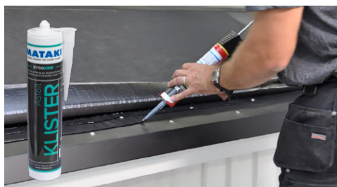
7. Vik upp nedersta kanten på första våden och lägg 3 strängar MATAKI Asfaltklister längs plåten. Vid montage av Haloten® STEEL fäster dess klisterkanter utan klister mot fotplåten. Värm med varmluftspistol om det är kallt ute.
