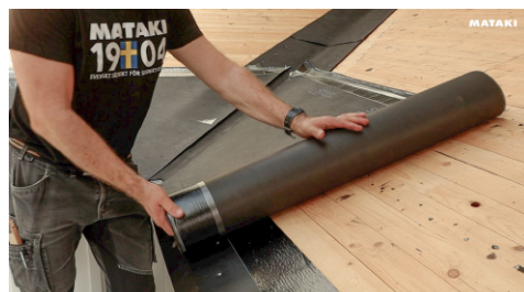
6. Rulla ut första våden underlagsduk och fäst i ovkant.
