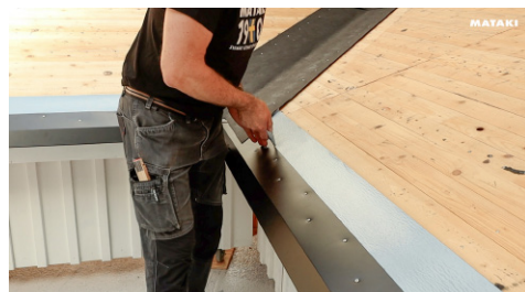
3. Använd baksidan på en kniv för att skära releaseremsan.
