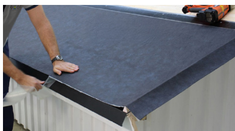
8. Dra därefter av releasen och tryck till för bra vidhäftning.
