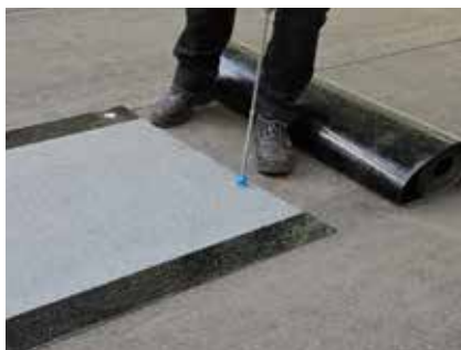
4. Fäst in rännalsvåden mekaniskt i underlaget.
