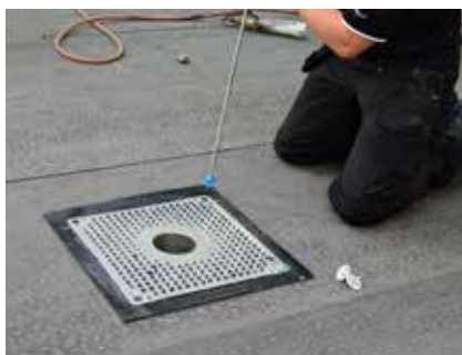
1. Placera brunnen och fäst in brunnsens alla fyra hörn i underlaget.
