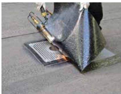
2. Montera rännalsvåd 1 x 1 m över brunnen.
