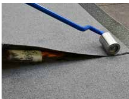
6. Rännaldalen är ett naturligt riskområde på taket. Var extra noga vid skarvar i rännaldalar.
