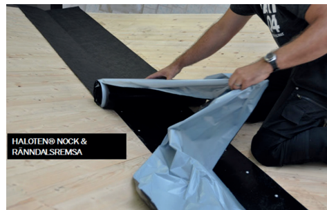
3. Rulla ut Haloten® Nock- & Rännalsremsa över rännalsplåten, dra samtidigt av releasefilmen.
