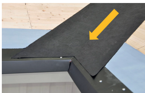
4. Skär av kanten längs med plåten.
