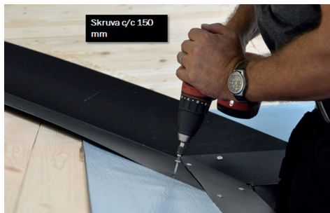
2. Skruva fast rännalsplåten c/c 150 mm.
