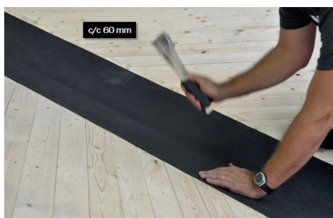
5. Klamra eller spika Nock- & Rännalsremsan c/c 60 mm.
