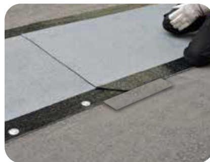
5b. Alternativt förstärks skarvarna med underliggande remsa av minst YEP 3500 0,3 x 1 m.
