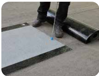
4. Fäst in rännalsvåden mekaniskt i underlaget.
