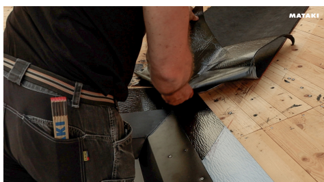
5. Ta bort releaseremsa på Halotennock & rännalsremsan och sammanfoga denna med fotplåtsremsan.
