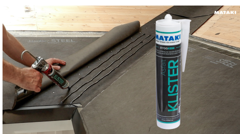
11. Klistra tvärskarven på underlagsduken mot Halotennock & rännalsremsa med tre strängar Matakli asfaltklistre .
