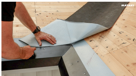
2. Skär Halotennock & rännalsremsan längs fotplåtskanten.
