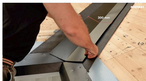
6. Montera rännalsplåten i rännalen. rännalsplåten skall vara minst 300 mm bred.
