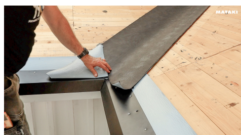
9. Renskar Halotennock & rännalsremsan ett par centimeter upp längs fotplåtens kant.
