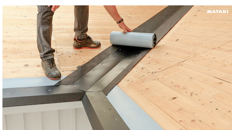
8. Rulla ut Halotennock & rännalsremsan ovanpå rännalsplåten.
