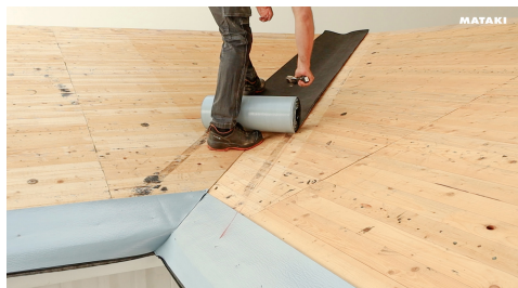
1. Rulla ut och fäst in Halotennock & rännalsremsan med klamring.
