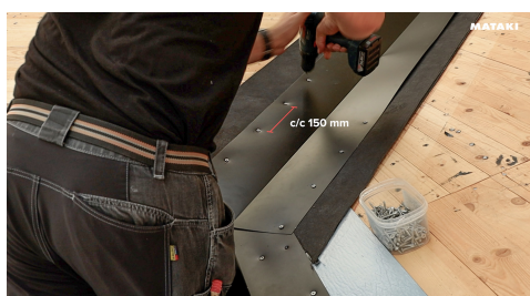
7. Skruva fast rännalsplåten c/c 150 mm.
