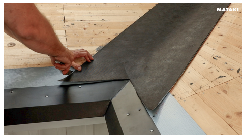
3. Skära releasefilmen på fotplåtsremsan längs Halotennock & rännalsremsan kant
