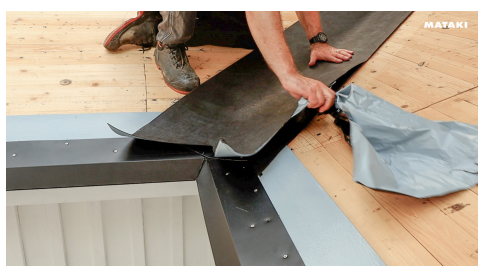
10. Dra bort releaseremsa på Halotennock & rännalsremsa och tryck till mot rännalsplåten ordentligt.
