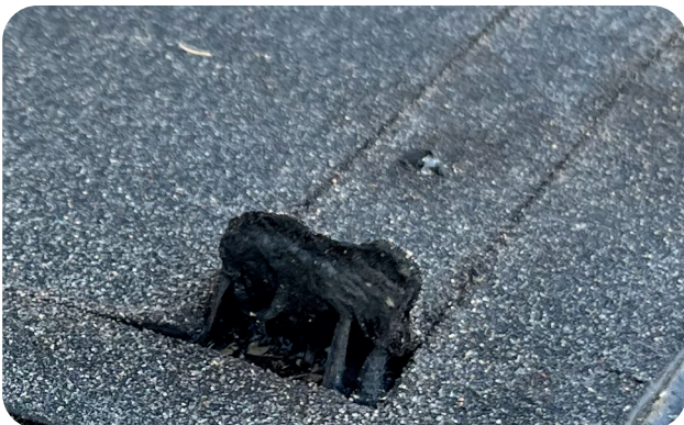
Remsan lossas.
