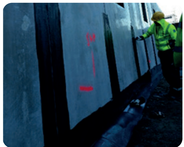
Exempel på ytor som inte tillräckligt bearbetats innan påförande av primer och tätskikt. Notera den blanka ytan.
