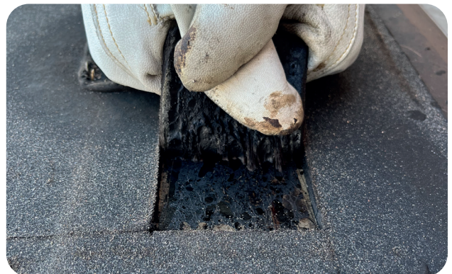
Vidhäftning kontrolleras genom att bitumentrådarna uppstår, och att remsan inte kan lossas med handkraft.
