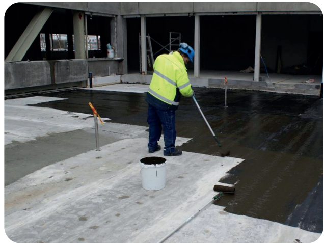
Strykning av ytan med primer. Beroende på underlagets beskaffenhet kan denna process få utföras i flera omgångar för att uppnå full täckning.
