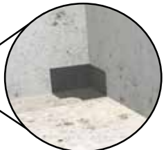
Hörntätningssremsa monteras alltid i in- och utvändiga hörn
