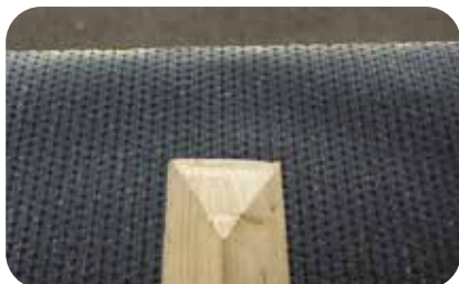
1. Montera trekantslisterna ovanpå underlagstäckningen.
