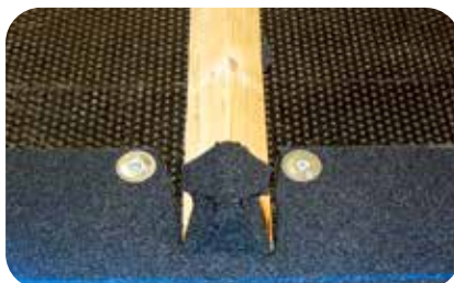
2. Skär ut detaljen och svetsa mot trekantstlisten. Fäst in fotkappan mekaniskt i underlaget.
