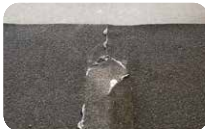
5. Skär till detaljen och svetsa mot listen. Var noga med att använda rätt mängd värme för att undvika stora uttrinningar av asfalt.
