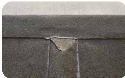
5. Avsluta med att montera nockkappa ned till trekantslisten.
