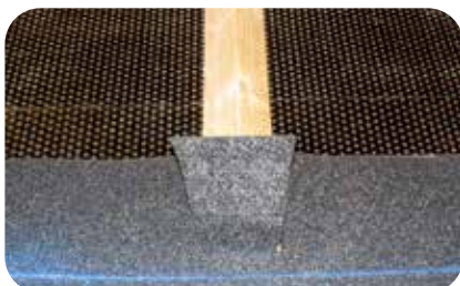
1. Montera lister ovanpå underlagstäckningen, fortsätt sedan med fotkappan. Skär ut för listen enligt bild.
