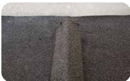
4. Skär ut en remsa av Mataki Listtak och helsvetsa mot listen.
