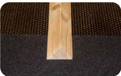
1. Montera lister ovanpå underlagstäckning och fotkappa.
