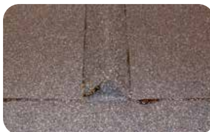
5. Montera Mataki listtak mellan trekantslisterna.
