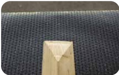
1. Montera trekantslisterna ovanpå underlagstäckningen.
