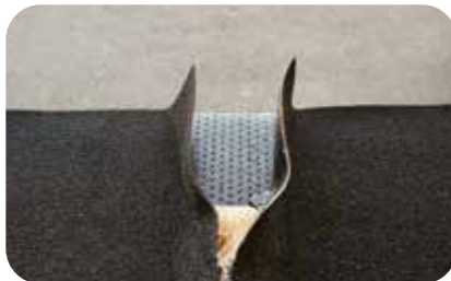
2. Montera Mataki Listtak mellan trekantstlisterna. Våderna ska mötas på toppen av trekantstlisten.
