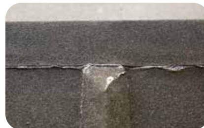
6. Avsluta med att monteranockkappa ned till trekantstlisten.
