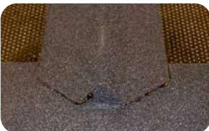
4. Svetsa remsan mot underlaget och listens avslut. Var extra noga med att använda rätt mängd värme för att undvika för stora utrinningar av asfalt.
