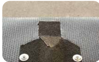
3. Fäst in remsan mekaniskt i underlaget.
